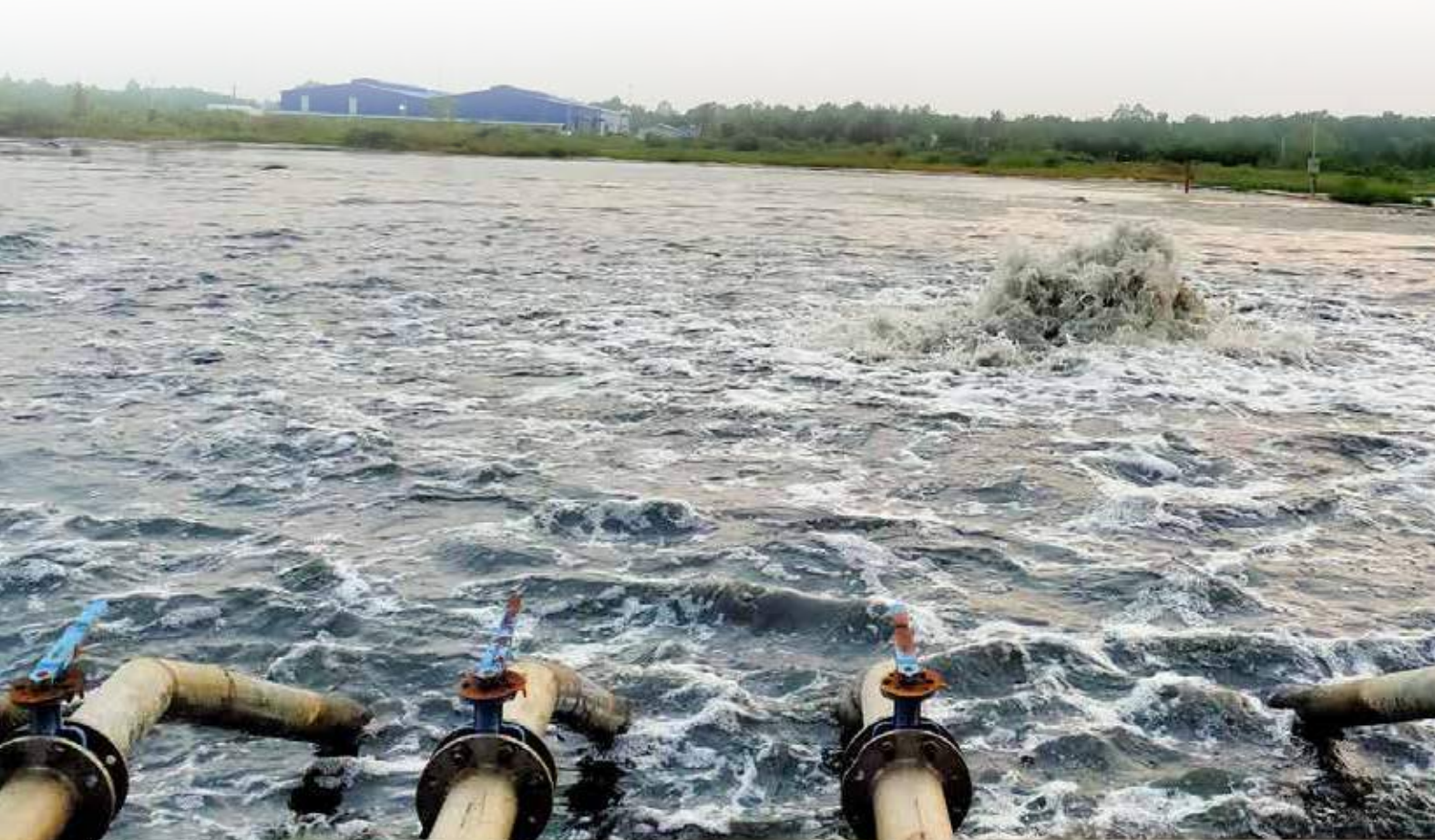
Hệ thống xử lý nước thải tại Nhà máy Tapiotek
